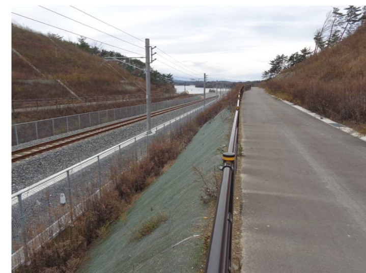
⑨西工区(鷹打山⇒松島方面)
