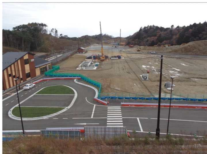
①東工区(館跡付近⇒金山方面)
