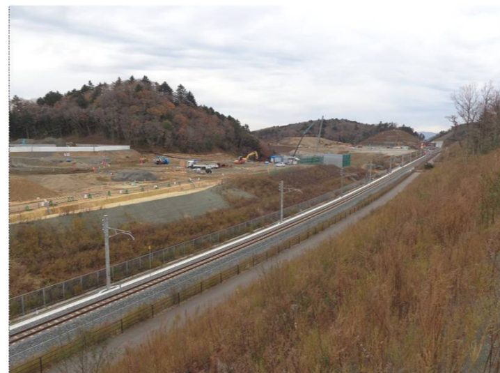
④中工区(新山⇒金山方面)
