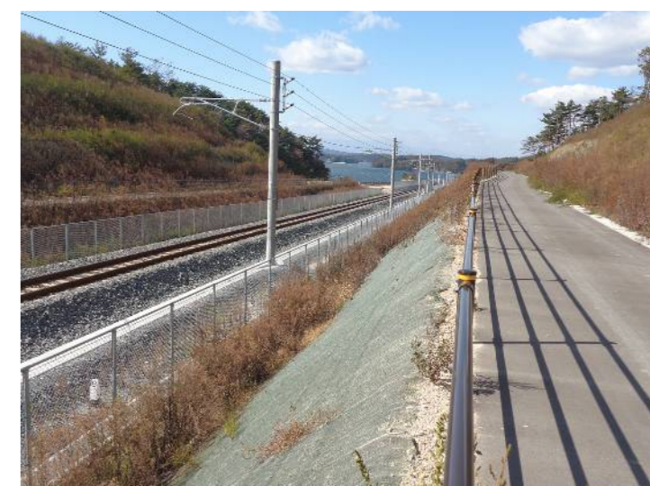
⑨西工区(鷹打山⇒松島方面)
