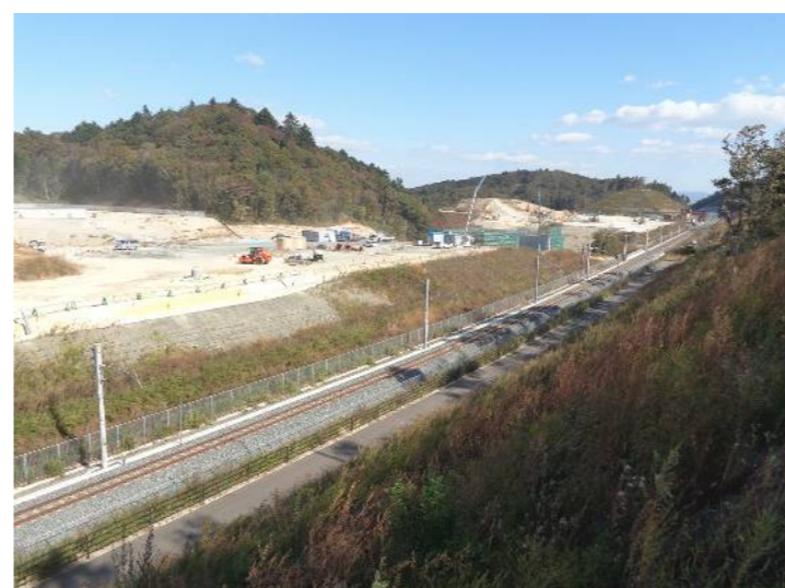
④中工区(新山⇒金山方面)
