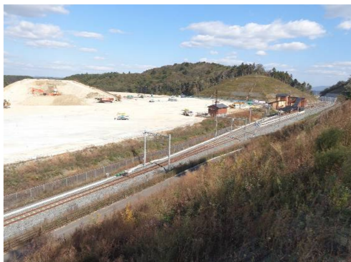
②東工区(金山⇒館跡付近方面)
