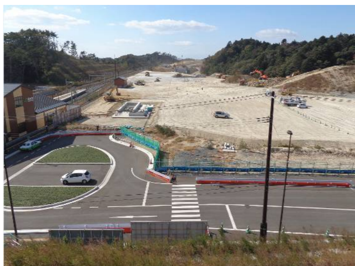
①東工区(館跡付近⇒金山方面)
