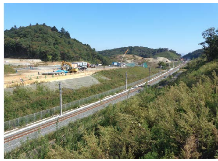
④中工区(新山⇒金山方面)
