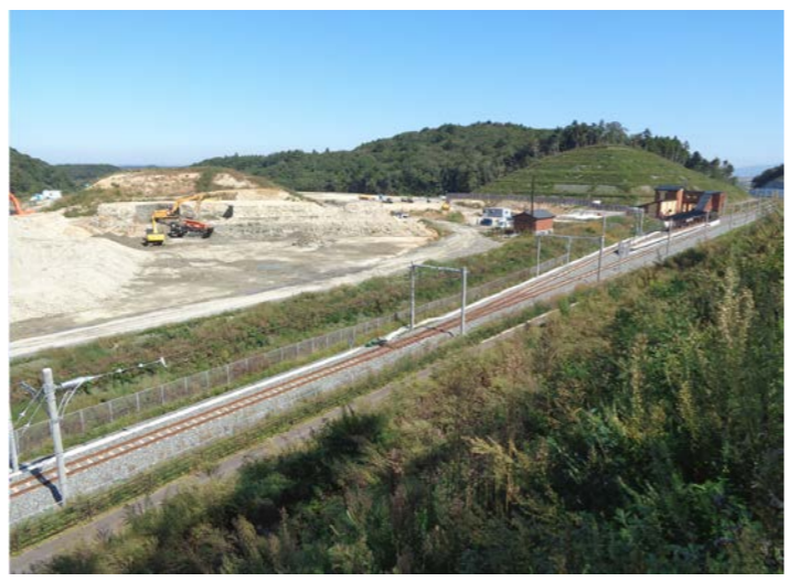
②東工区(金山⇒館跡付近方面)
