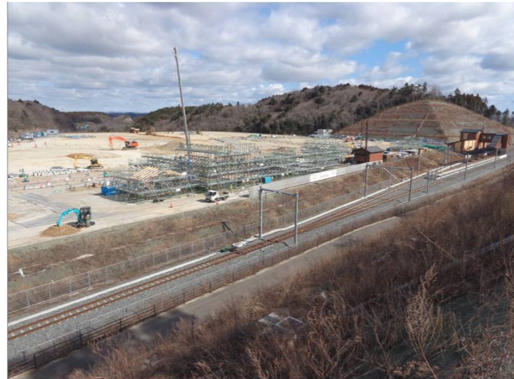
②東工区(金山⇒館跡付近方面)
