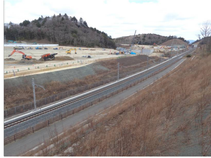
④中工区(新山⇒金山方面)
