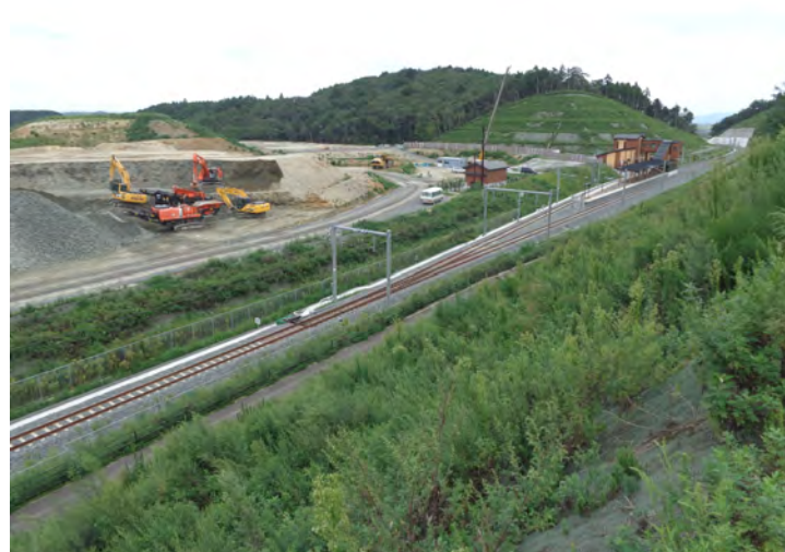
②東工区(金山⇒館跡付近方面)
