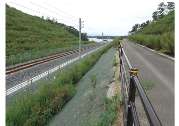
⑨西工区(鷹打山⇒松島方面)
