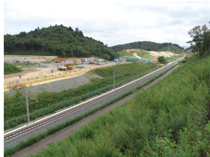
④中工区(新山⇒金山方面)
