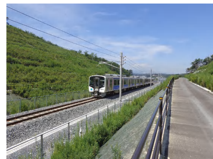
⑨西工区(鷹打山⇒松島方面)
