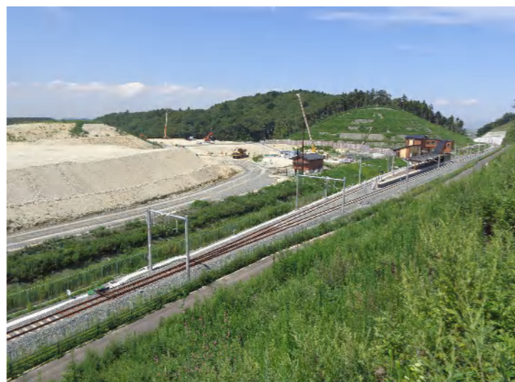
②東工区(金山⇒館跡付近方面)
