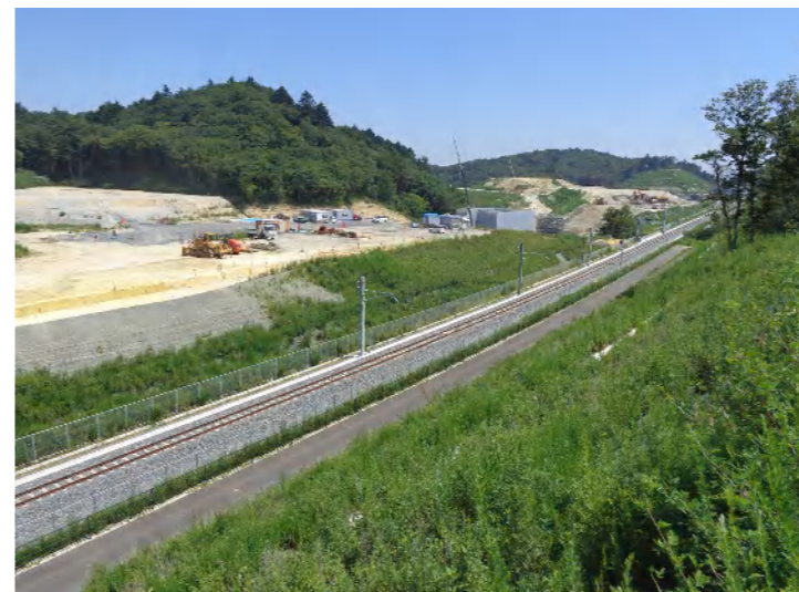
④中工区(新山⇒金山方面)
