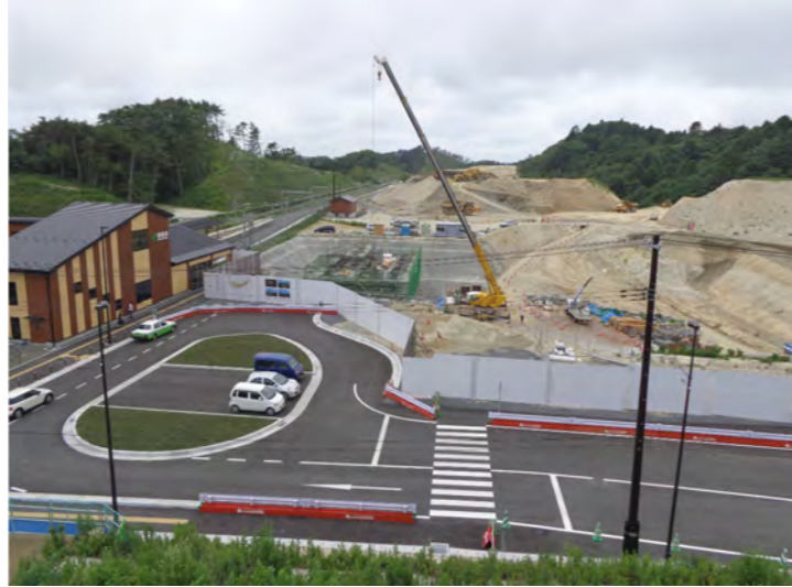
①東工区(館跡付近⇒金山方面)
