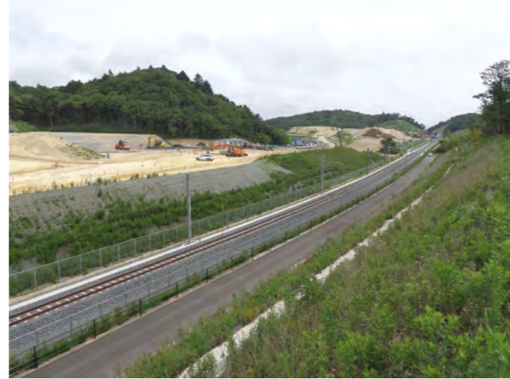
④中工区(新山⇒金山方面)
