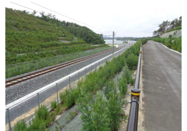
⑨西工区(鷹打山⇒松島方面)
