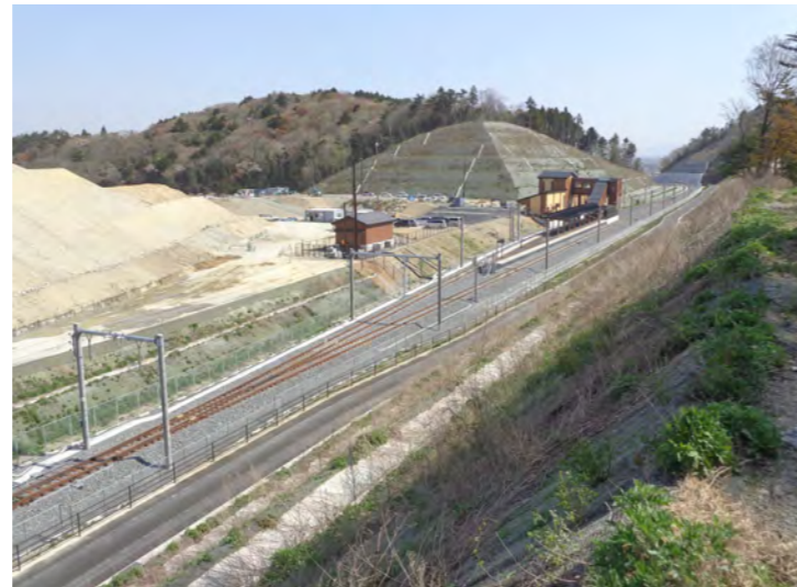
②東工区(金山⇒館跡付近方面)
