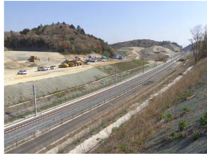
④中工区(新山⇒金山方面)
