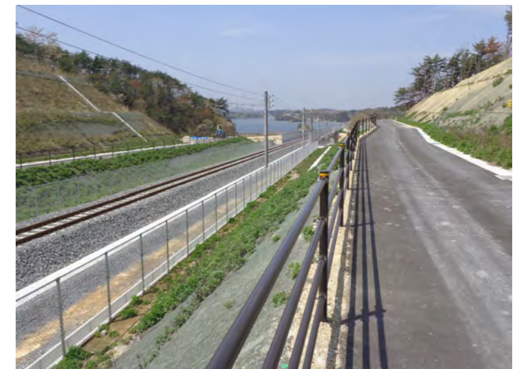
⑨西工区(鷹打山⇒松島方面)
