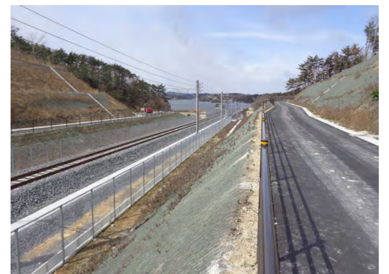
⑨西工区(鷹打山⇒松島方面)
