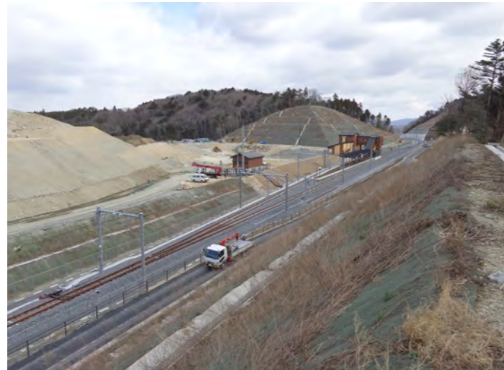
②東工区(金山⇒館跡付近方面)
