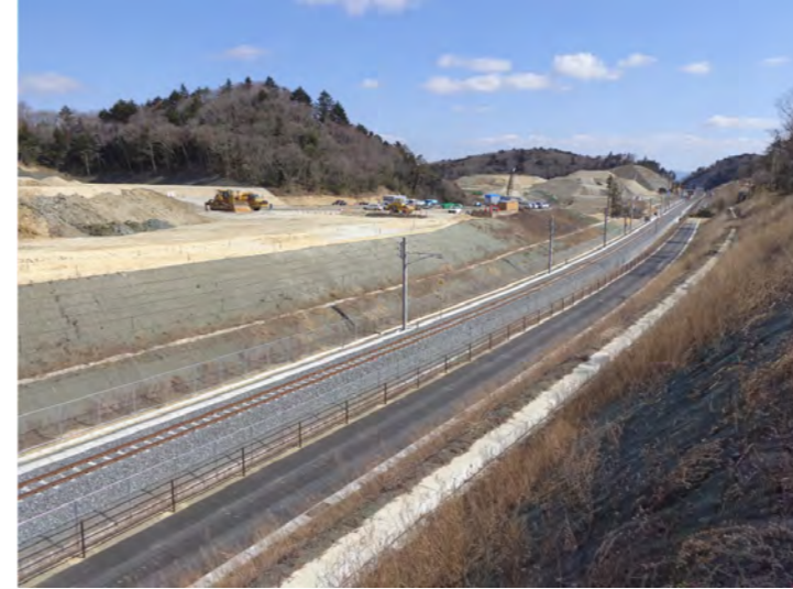
④中工区(新山⇒金山方面)
