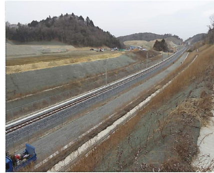
④中工区(新山⇒金山方面)
