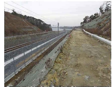
⑨西工区(鷹打山⇒松島方面)
