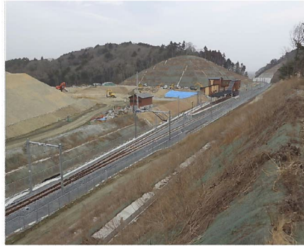
②東工区(金山⇒館跡付近方面)
