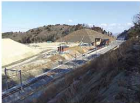
②東工区(金山⇒館跡付近方面)
