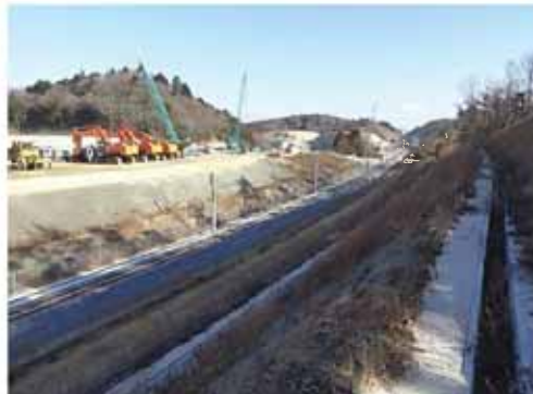
④中工区(新山⇒金山方面)
