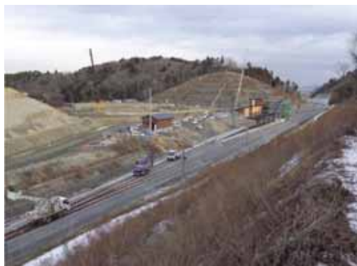
②東工区(金山⇒館跡付近方面)
