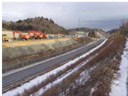
④中工区(新山⇒金山方面)
