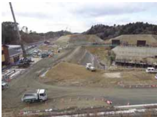
①東工区(館跡付近⇒金山方面)
