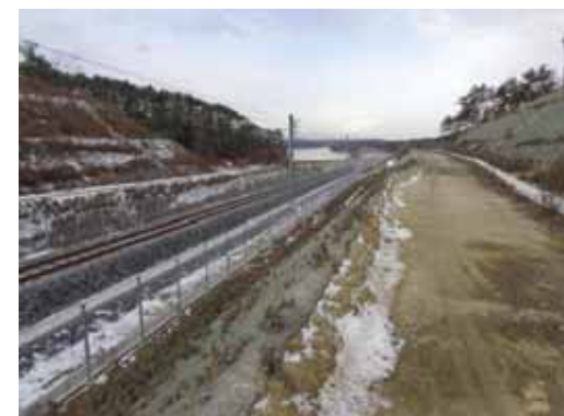
⑨西工区(鷹打山⇒松島方面)
