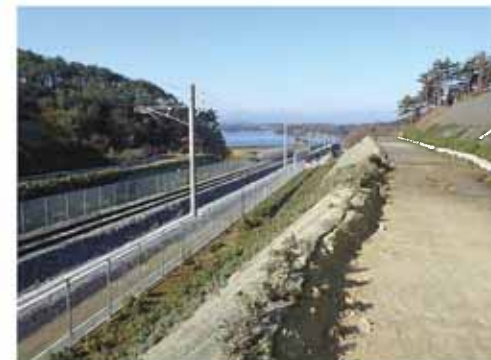
⑨西工区(鷹打山⇒松島方面)
