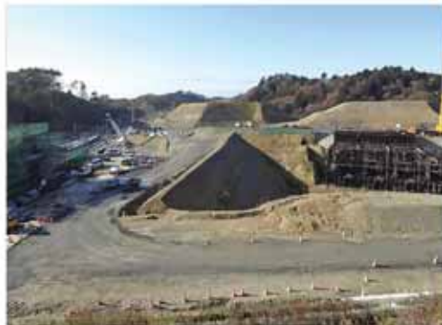
①東工区(館跡付近⇒金山方面)
