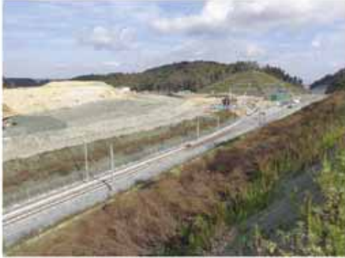
東工区(金山 館跡付近方面)
