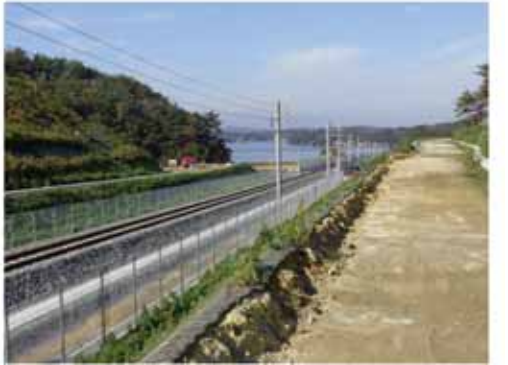
西工区(鷹打山 松島方面)
