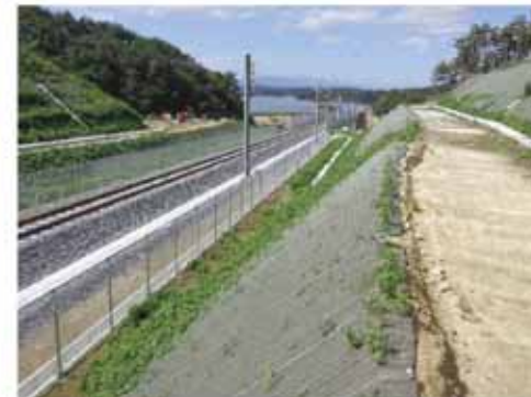
西工区(鷹打山 松島方面)
