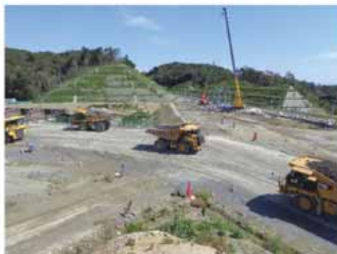
東工区(金山 館跡付近方面)
