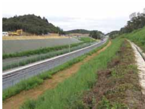
④中工区(新山⇒金山方面)
