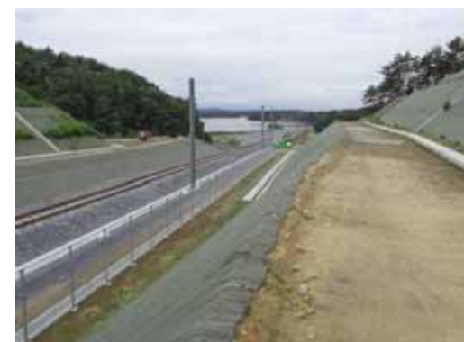
⑨西工区(鷹打山⇒松島方面)
