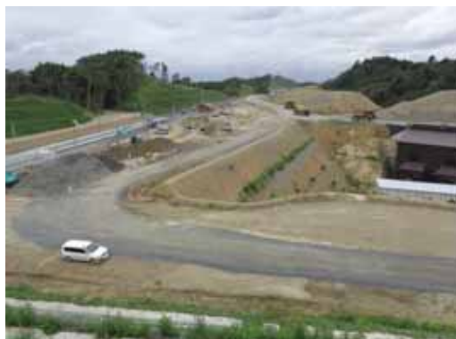
①東工区(館跡付近⇒金山方面)
