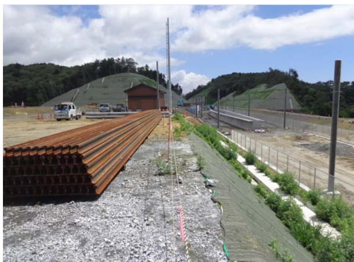
②東工区(金山⇒館跡付近方面)
