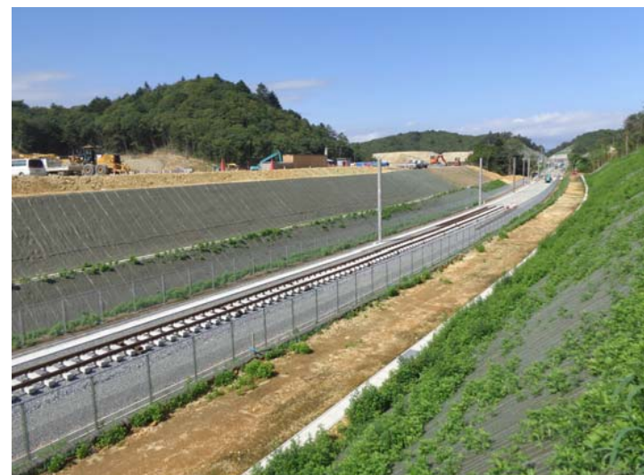
④中工区(新山⇒金山方面)
