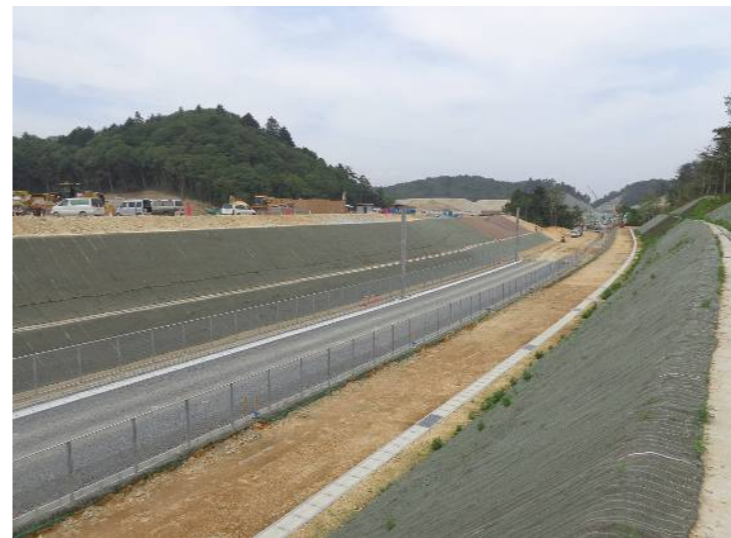
④中工区(新山⇒金山方面)
