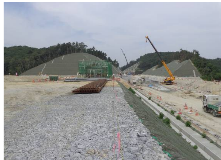
②東工区(金山⇒館跡付近方面)
