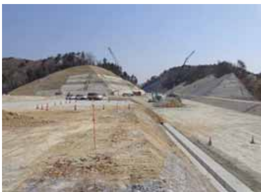
②東工区(金山⇒館跡付近方面)
