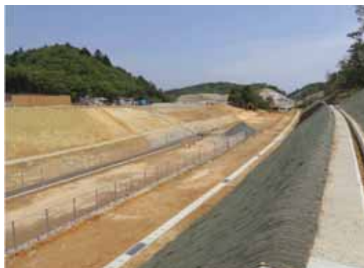
④中工区(新山⇒金山方面)
