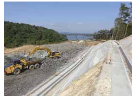
⑨西工区(鷹打山⇒松島方面)
