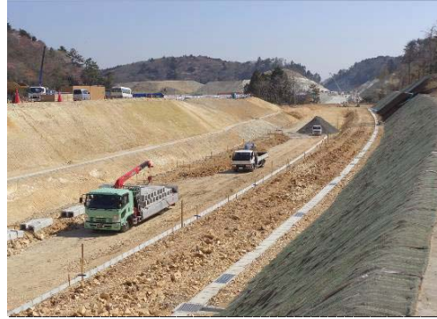
④中工区(新山⇒金山方面)
