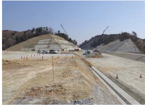
②東工区(金山⇒館跡付近方面)
