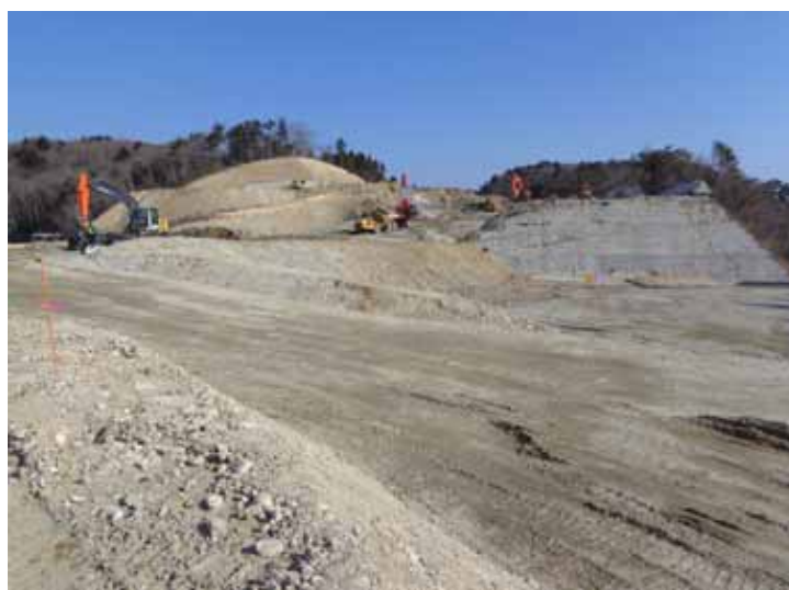
東工区(金山 館跡付近方面)
