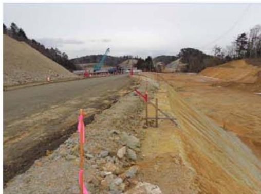
④中工区(新山⇒金山方面)
