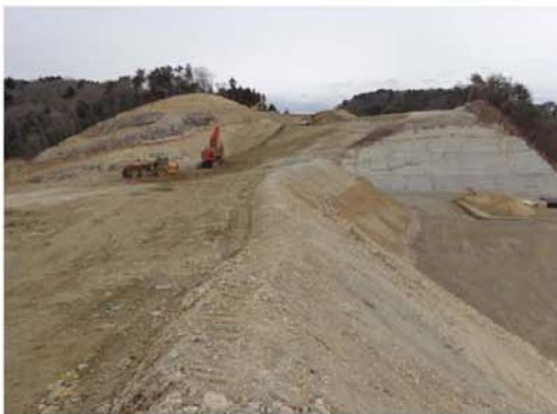
②東工区(金山⇒館跡付近方面)
