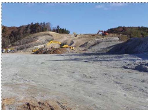
②東工区(金山⇒館跡付近方面)
