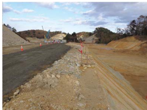
④中工区(新山⇒金山方面)
