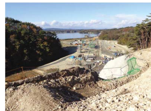
⑨西工区(鷹打山⇒松島方面)
