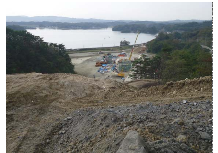
⑨西工区(鷹打山⇒松島方面)
