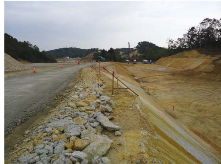
④中工区(新山⇒金山方面)
