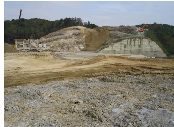
②東工区(金山⇒館跡付近方面)
