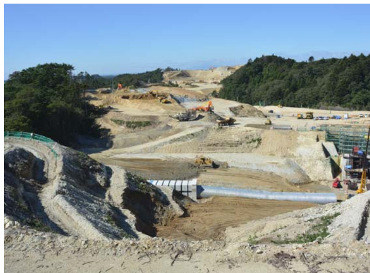
①東工区(館跡付近⇒金山方面)
