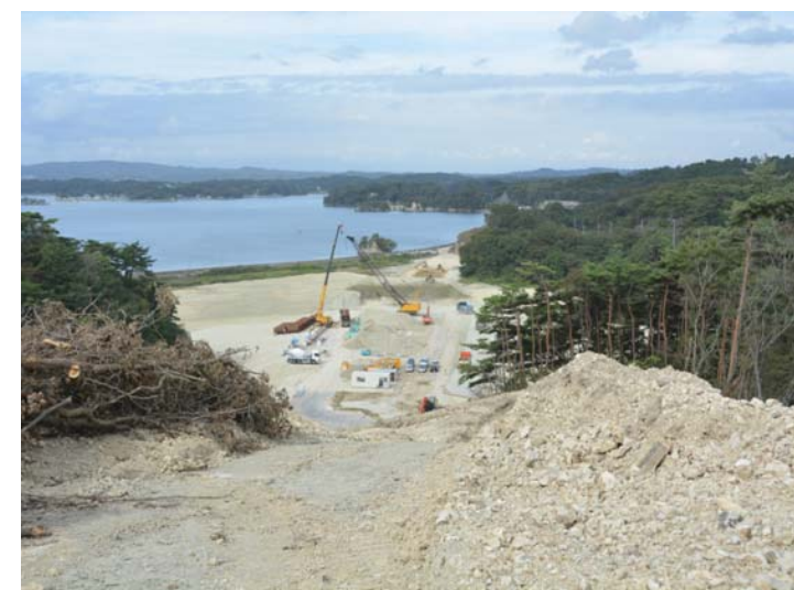
⑨西工区(鷹打山⇒松島方面)
