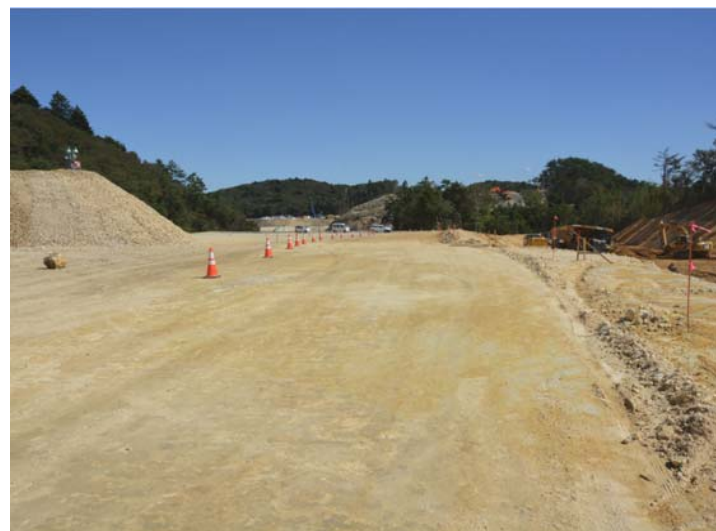
④中工区(新山⇒金山方面)
