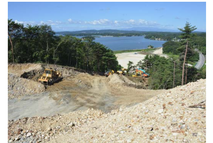
⑨西工区(鷹打山⇒松島方面)
