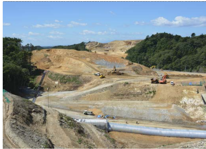
①東工区(館跡付近⇒金山方面)
