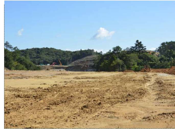
④中工区(新山⇒金山方面)
