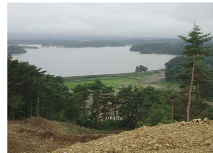
⑨西工区(鷹打山⇒松島方面)
