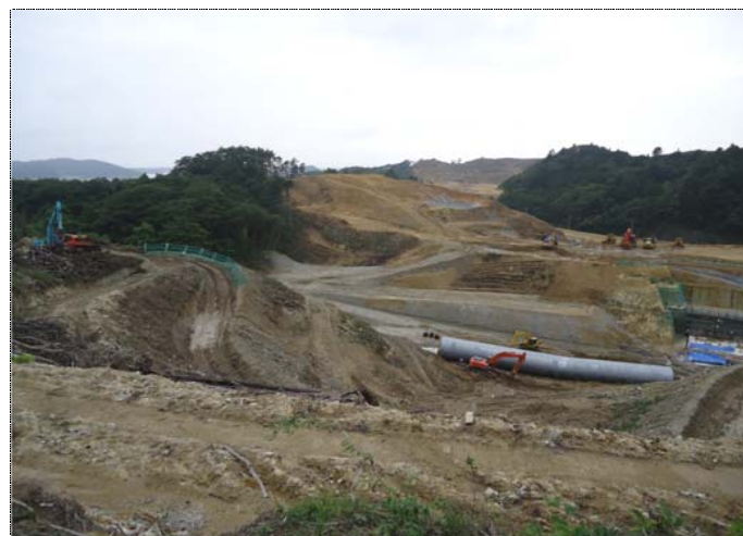
①東工区(館跡付近⇒金山方面)
