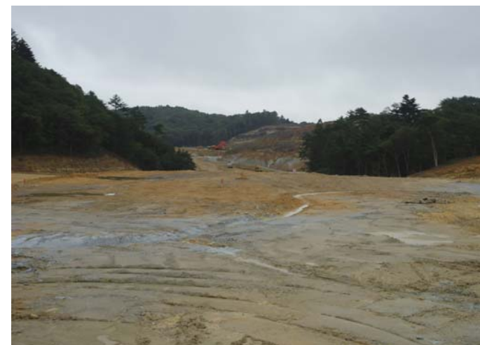
④中工区(新山⇒金山方面)
