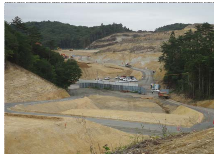
④中工区(新山⇒金山方面)
