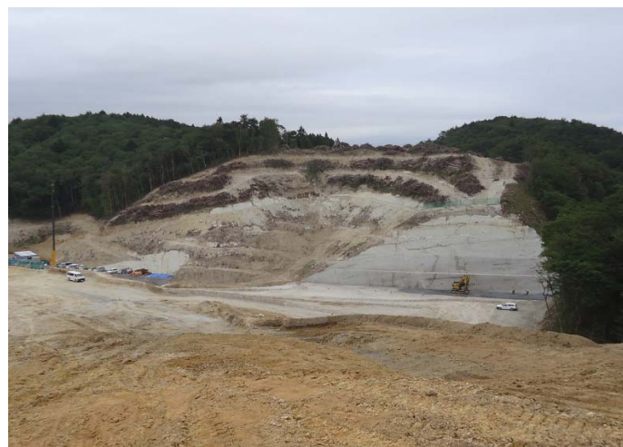
②東工区(金山⇒館跡付近方面)
