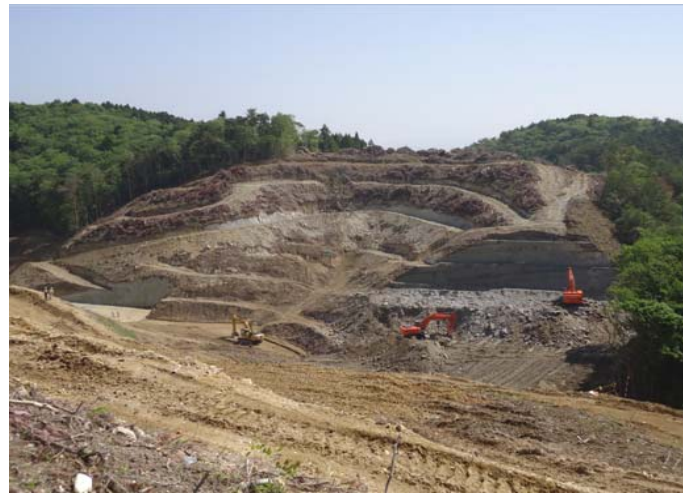
②東工区(金山⇒館跡付近方面)
