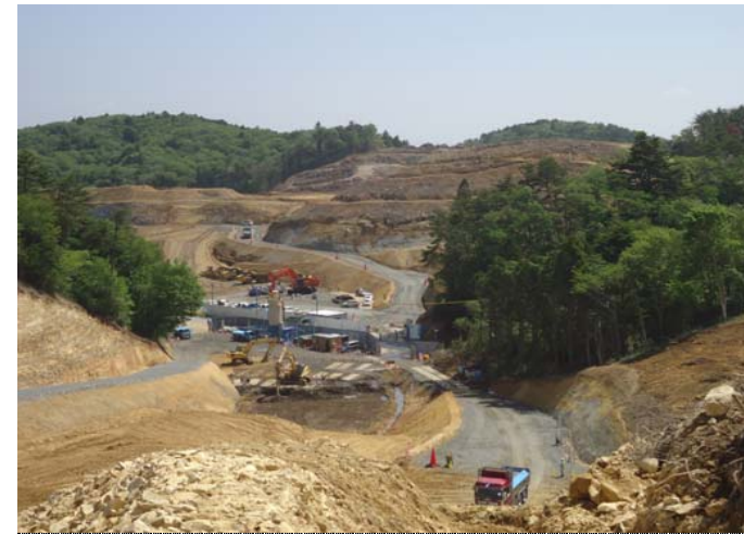
④中工区(新山⇒金山方面)
