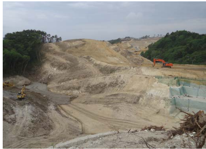
①東工区(館跡付近⇒金山方面)
