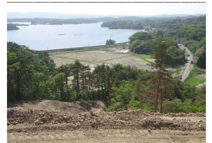
⑨西工区(鷹打山⇒松島方面)
