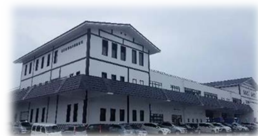
原釜荷捌き施設(相馬市)
