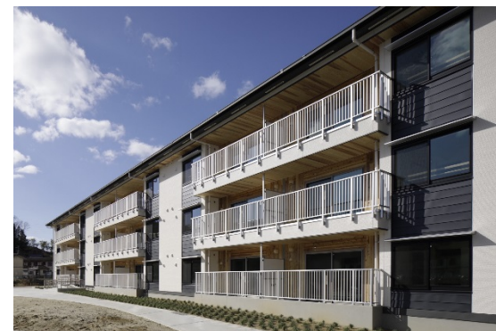
CLT工法を採用して整備された復興公営住宅(いわき市)
