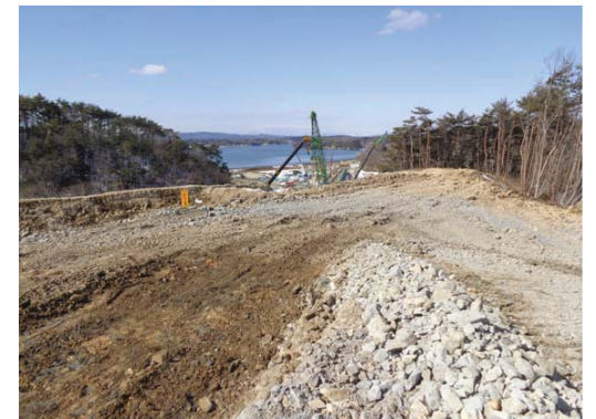
⑨西工区(鷹打山⇒松島方面)
