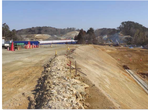
④中工区(新山⇒金山方面)
