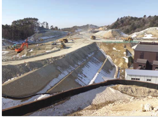
①東工区(館跡付近⇒金山方面)
